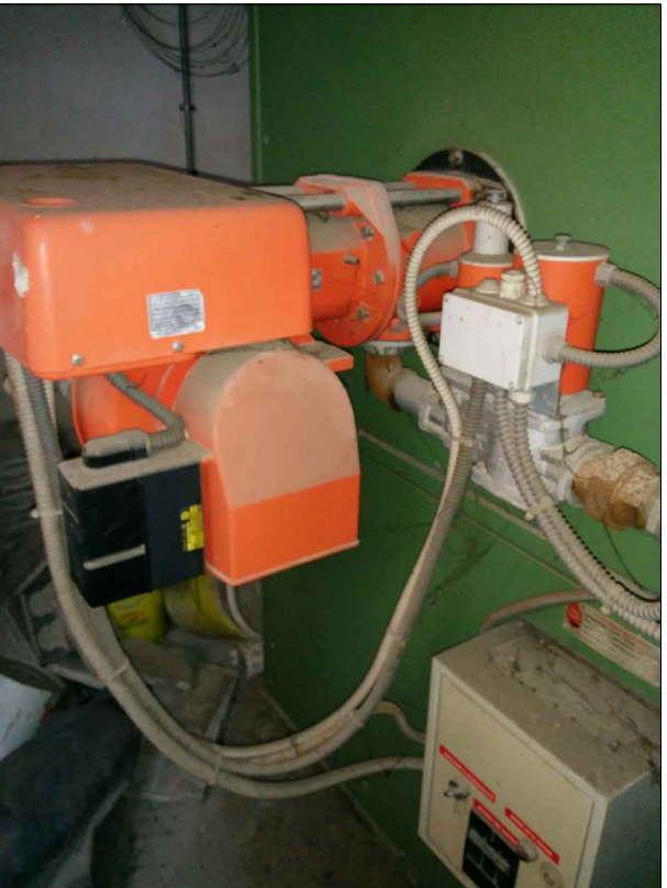
STATO DI FATTO GENERATORE DI CALORE E BRUCIATORE
